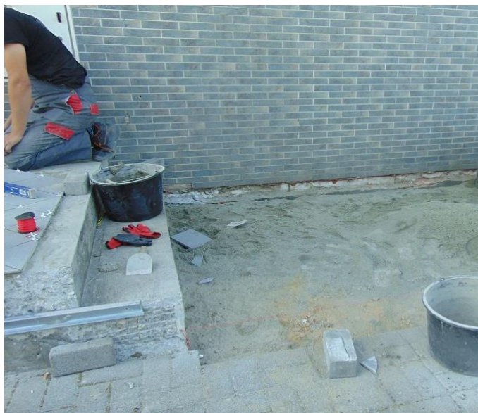
Demontaż kostki brukowej przy wejściu
