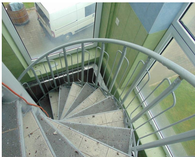
Wycinanie starych schodów
