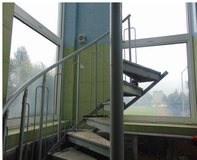
Demontaż konstrukcji schodów
