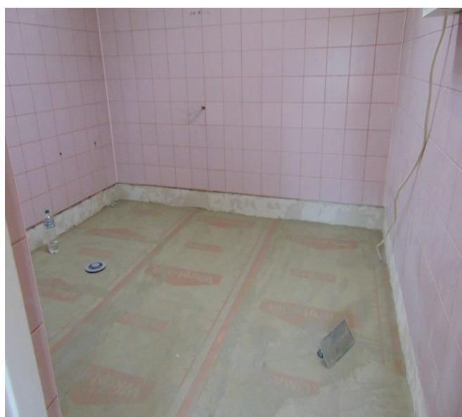
Nowa izolacja podłogi.
