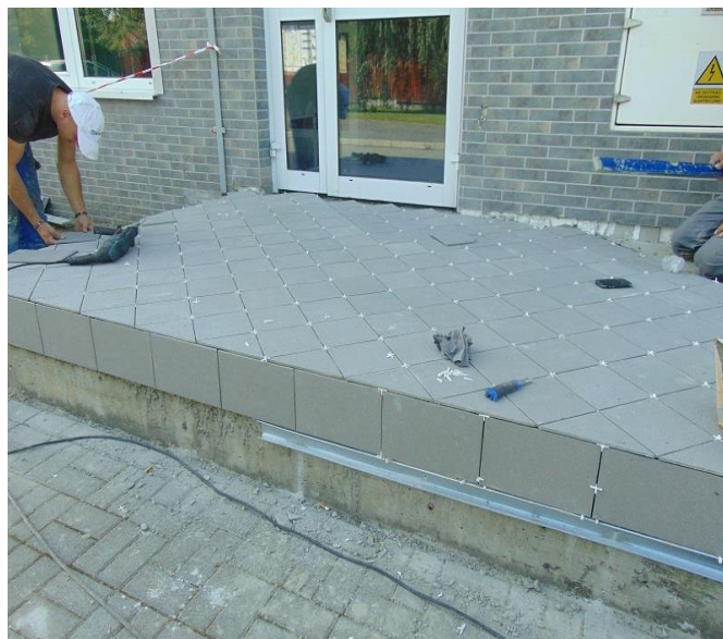
Klejenie płytek
