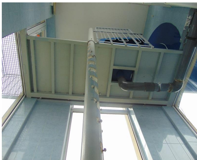
Demontaż konstrukcji schodów
