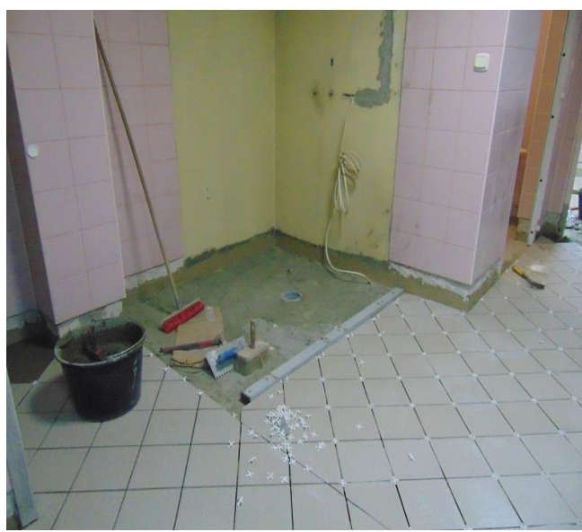
Układanie nowych płytek w pomieszczeniu strefy saun
