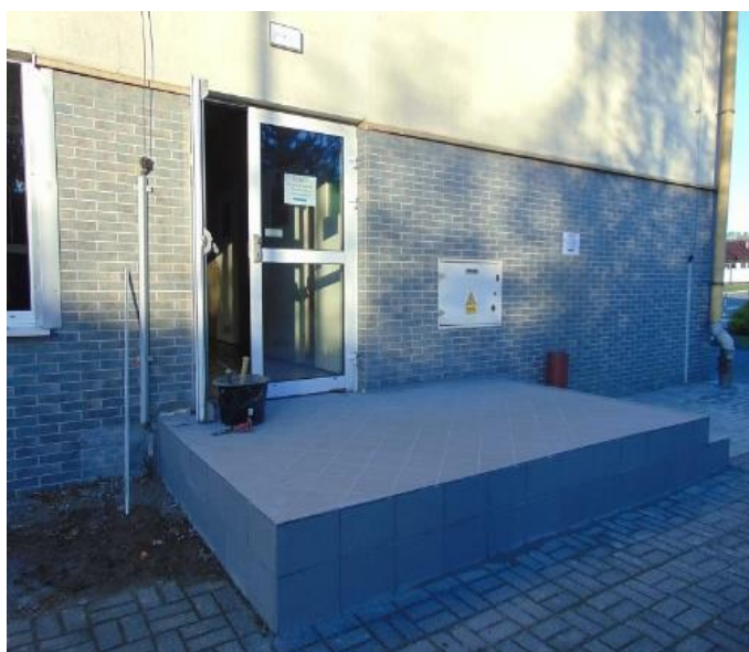
Demontaż drzwi bocznych
