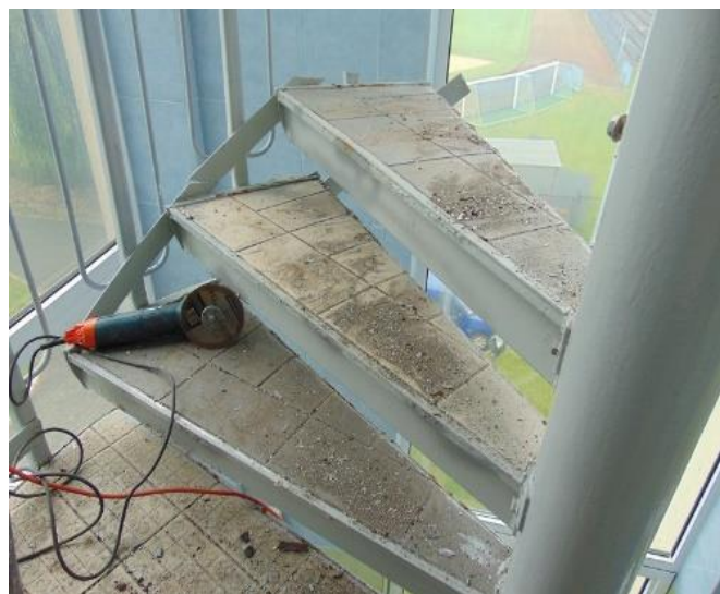
Wycinanie starych schodów
