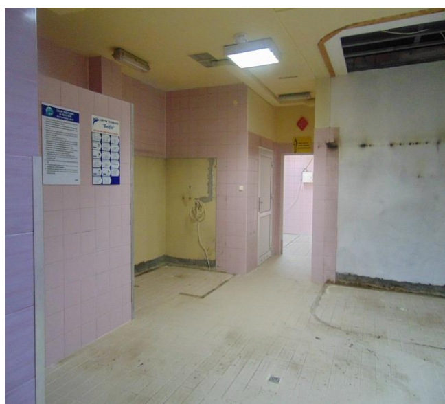
Pomieszczenie przygotowane do demontażu płytek
